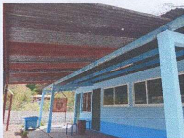
Foto1: Sustrucion de cubierta de lamina y estructura
