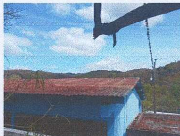
Foto2: Sustrucion de cubierta de lamina y estructura
