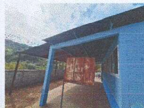
Foto 4: Sustrucion de columnas de metal por tubo estructural fundido con zapata
