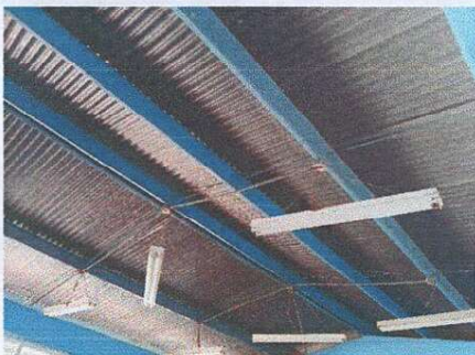
Foto 3: Reparacion del Sistema Electrico
